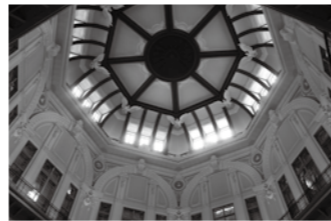
保存・復原により見事よみがえったドーム。
